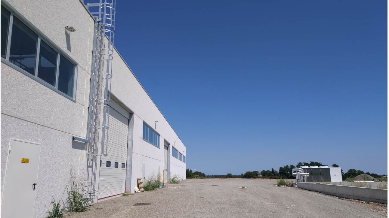
13. Vista del retro del capannone, dove verrà collegato l'ampliamento in progetto
