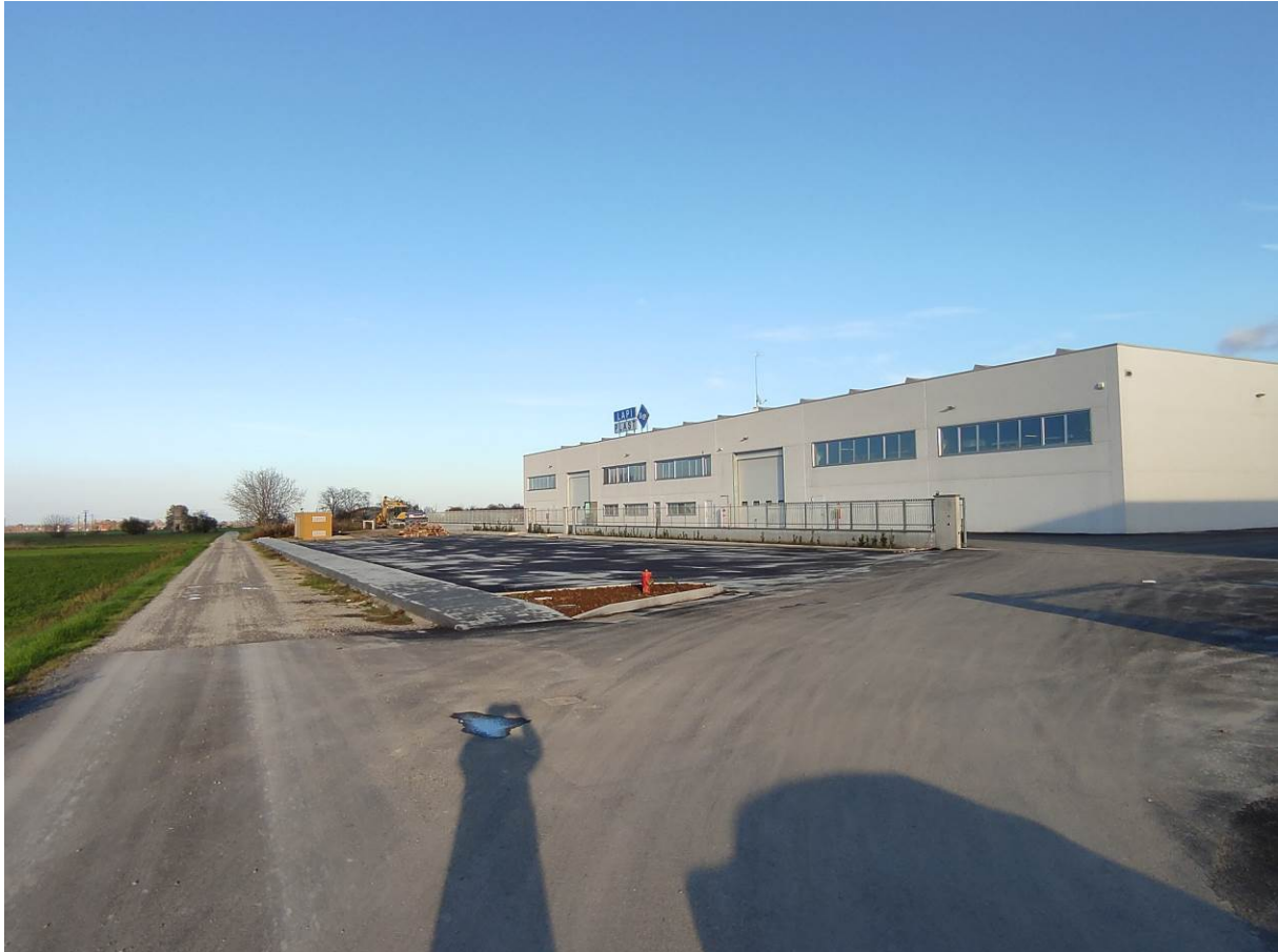
4. Immagine del capannone esistente e della carraia adiacente
